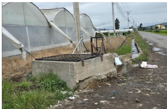
Canal de Riego Sistema Latacunga Salcedo Ambato
