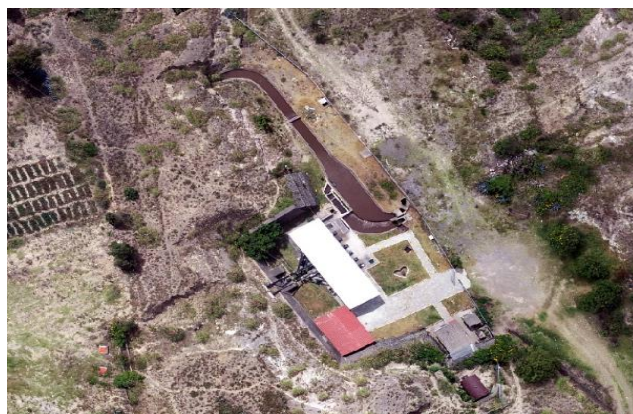
Estación de Bombeo Yambo
