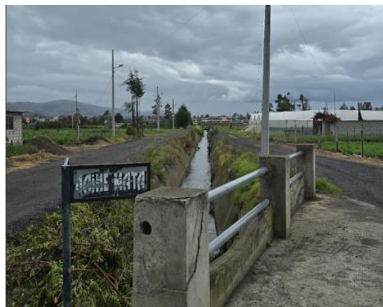
Canal de Riego Sistema Latacunga Salcedo Ambato
